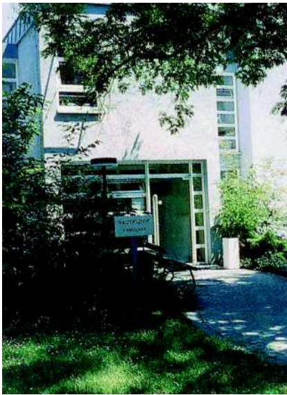
Abb. 1 Eingangsbereich der „alten“ Hautklinik bis 1996.
