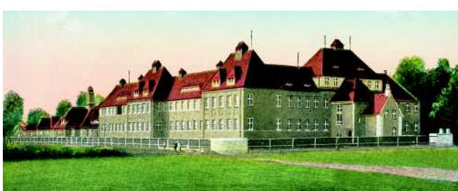
Abb. 1 Bezirkskrankenhaus der Amtshauptmannschaft Chemnitz-Rabenstein 1913.
