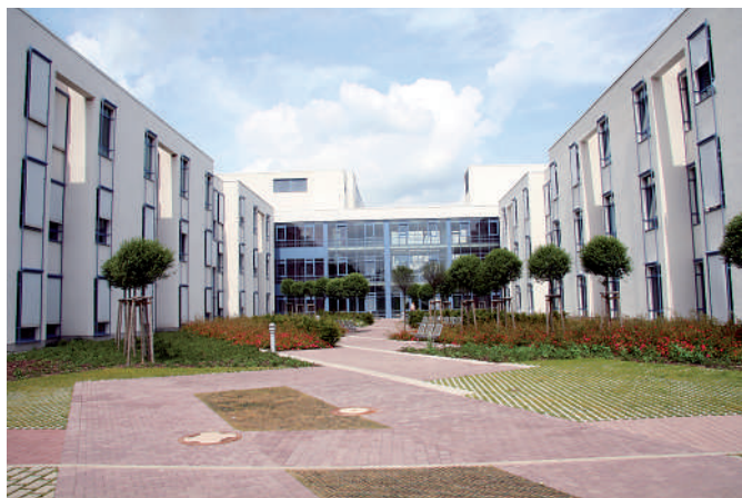
Abb. 1 Städtisches Klinikum Dessau. Die Stationsräume der Hautklinik und des Immunologischen Zentrums sind im Erdgeschoss und im 2. Stock des rechten Flügels untergebracht.
