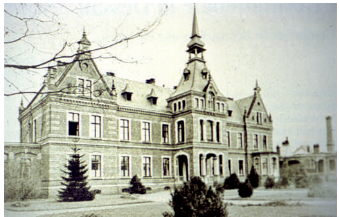
Abb. 1 Altes Kreiskrankenhaus von 1887.
