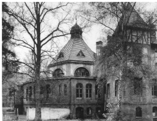
Abb. 7 Die Zentralbadeanstalt (aktueller Zustand).
