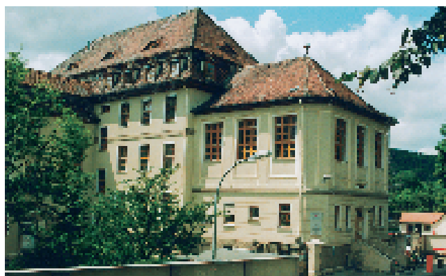
Abb. 2 Dermatologische Universitätsklinik Jena: Mitteltrakt mit Poliklinik (Erdgeschoss) und Hörsaal (Obergeschoss).
