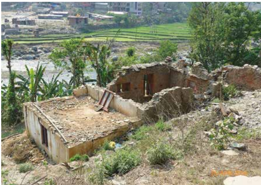
Zerstörung in Bahunipati
