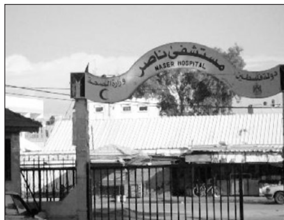
Figura 4. Entrada al Naser Hospital en Khan Younis.
