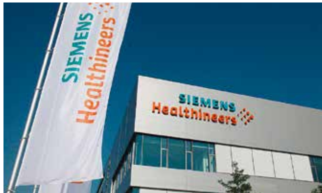
Das Büro- und Entwicklungsgebäude von Siemens Healthineers in Forchheim. Foto: Siemens Healthineers
