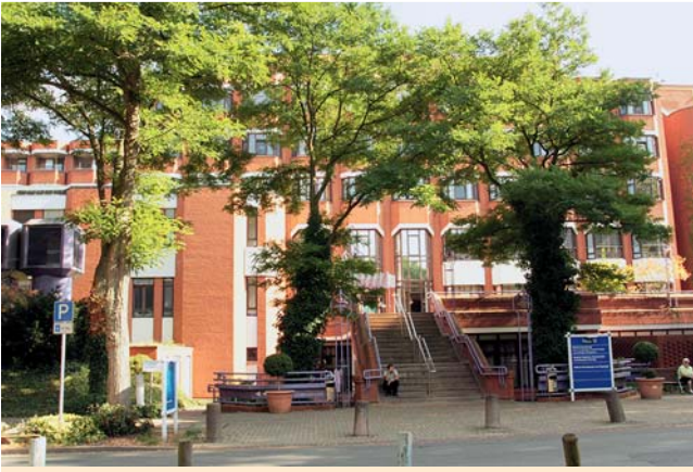
Abb. 12 Gebäude der Hautklinik heute.
