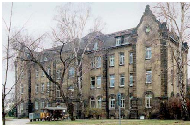
Abb. 2 Das Gebäude, Haus 15, der Hautklinik.
