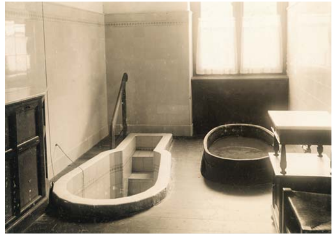
► Abb. 1 Historische Behandlungsräume.
